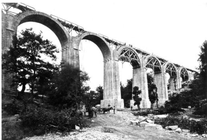
Viaduc de Las Hies en 1881 (vue vers l'est)
